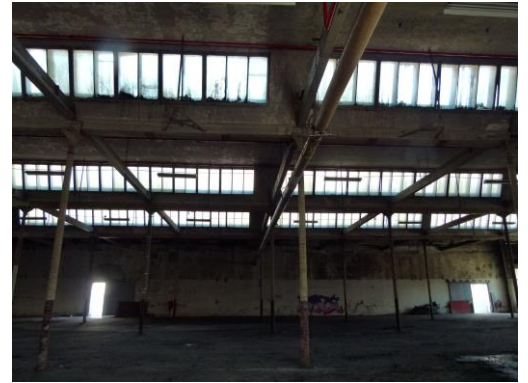
un shed, alignement d'ateliers étroits aux toits à deux pentes, dont une vitrée pour faire entrer la lumière.
