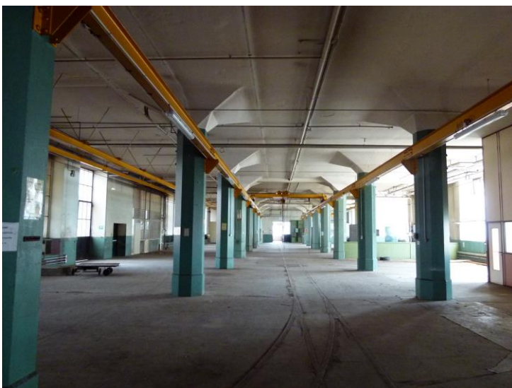
Intérieur du bâtiment ci-dessus.
